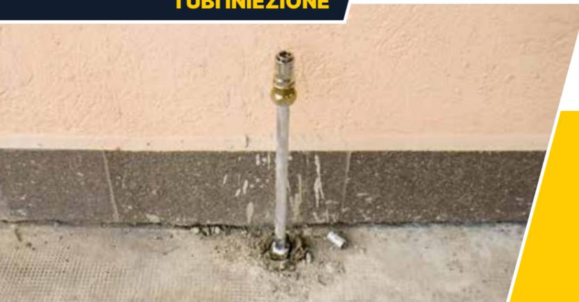
Il foro praticato alla base del muro permette di inserire una cannula di alluminio idonea all' iniezione in profondità della resina.
