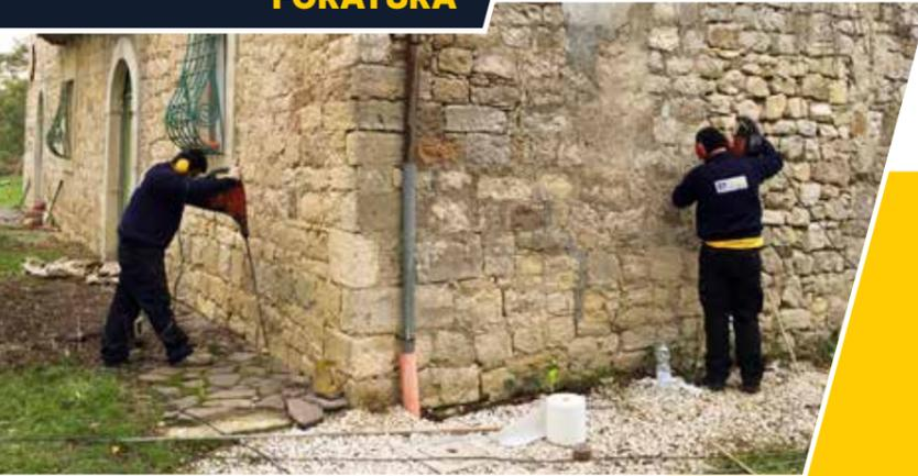
La fase di foratura viene normalmente eseguita con trapani manuali dotati di punte speciali, diametro 25 mm.
