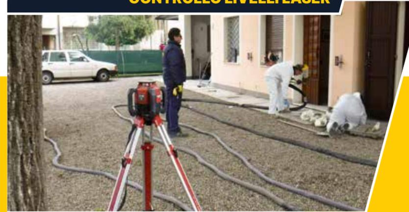
Durante la fase d' iniezione la risposta ed il sollevamento bilanciato della struttura sono monitorati in continuo con controllo laser di precisione.
