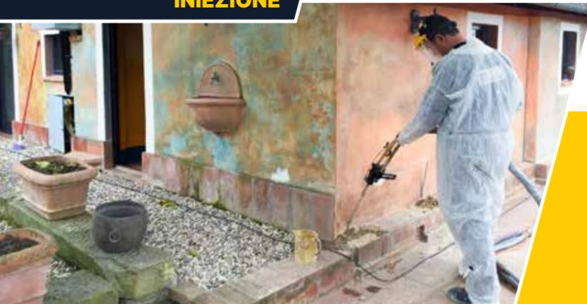
La fase d' iniezione avviene in modo lento e continuo, in modo da permettere la massima diffusione della resina nel terreno al di sotto della fondazione.
