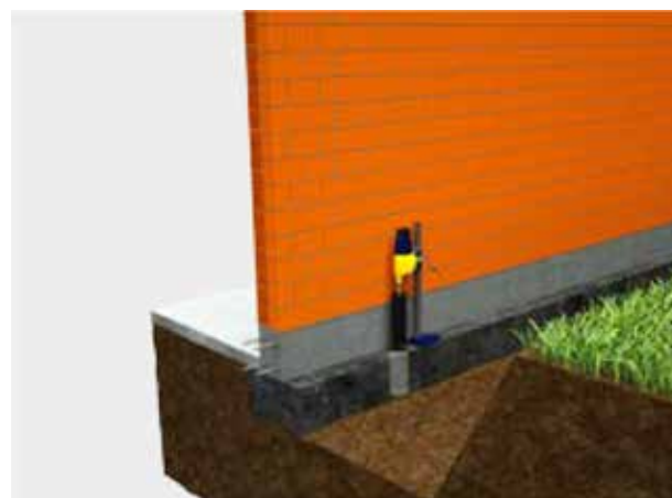
2 Carotaggio del basamento
