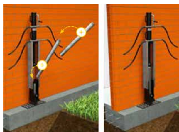
4 Pressoinfissione dei pali modulari
