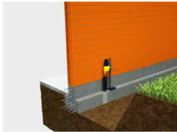
2 Carotaggio dell'ala di fondazione
