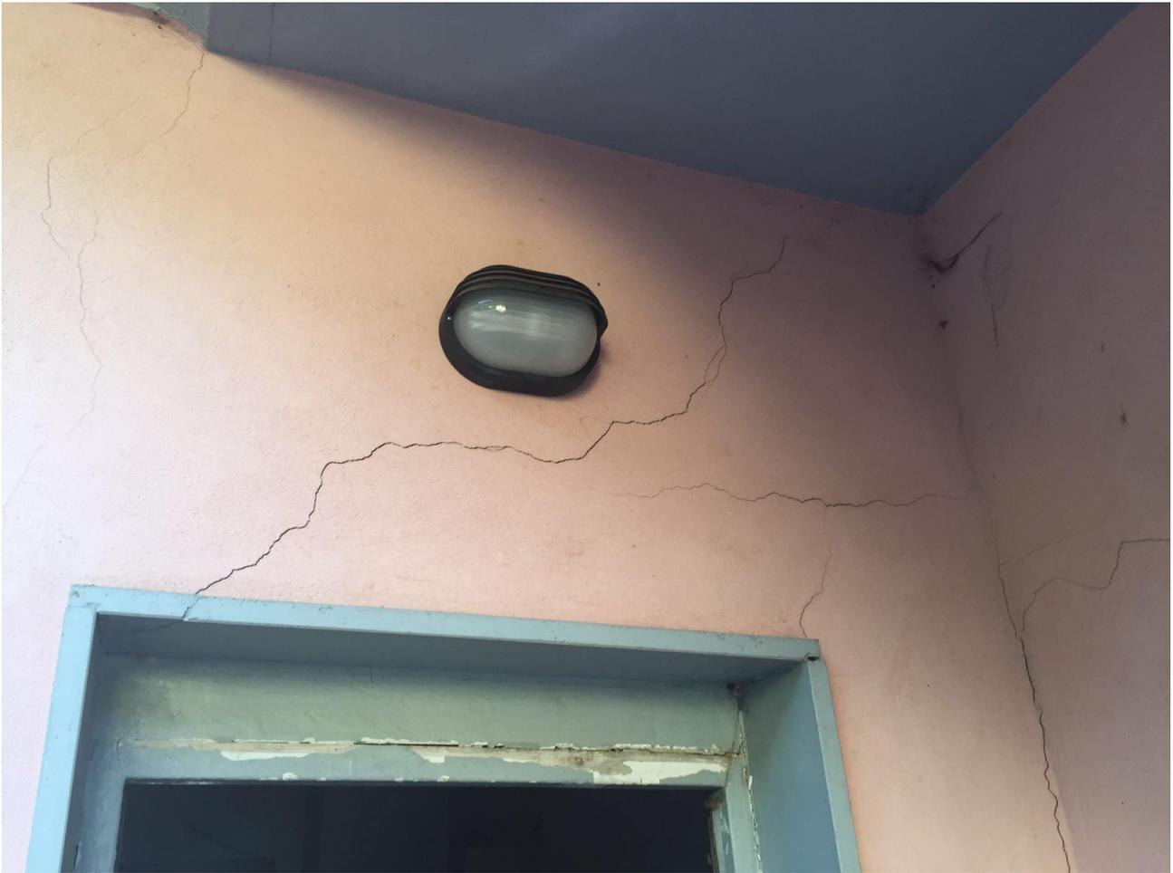
L'intervento è stato realizzato in 2 giorni, senza necessità di scavi mediante l'esecuzione fori di diametro 25 mm alla base delle murature da consolidare. In fase di cantiere sono state eseguite 2 prove penetrometriche pre e 2 post iniezione al fine di verificare i risultati di miglioramento ottenuti nel volume di terreno significativo per i carichi della struttura.
