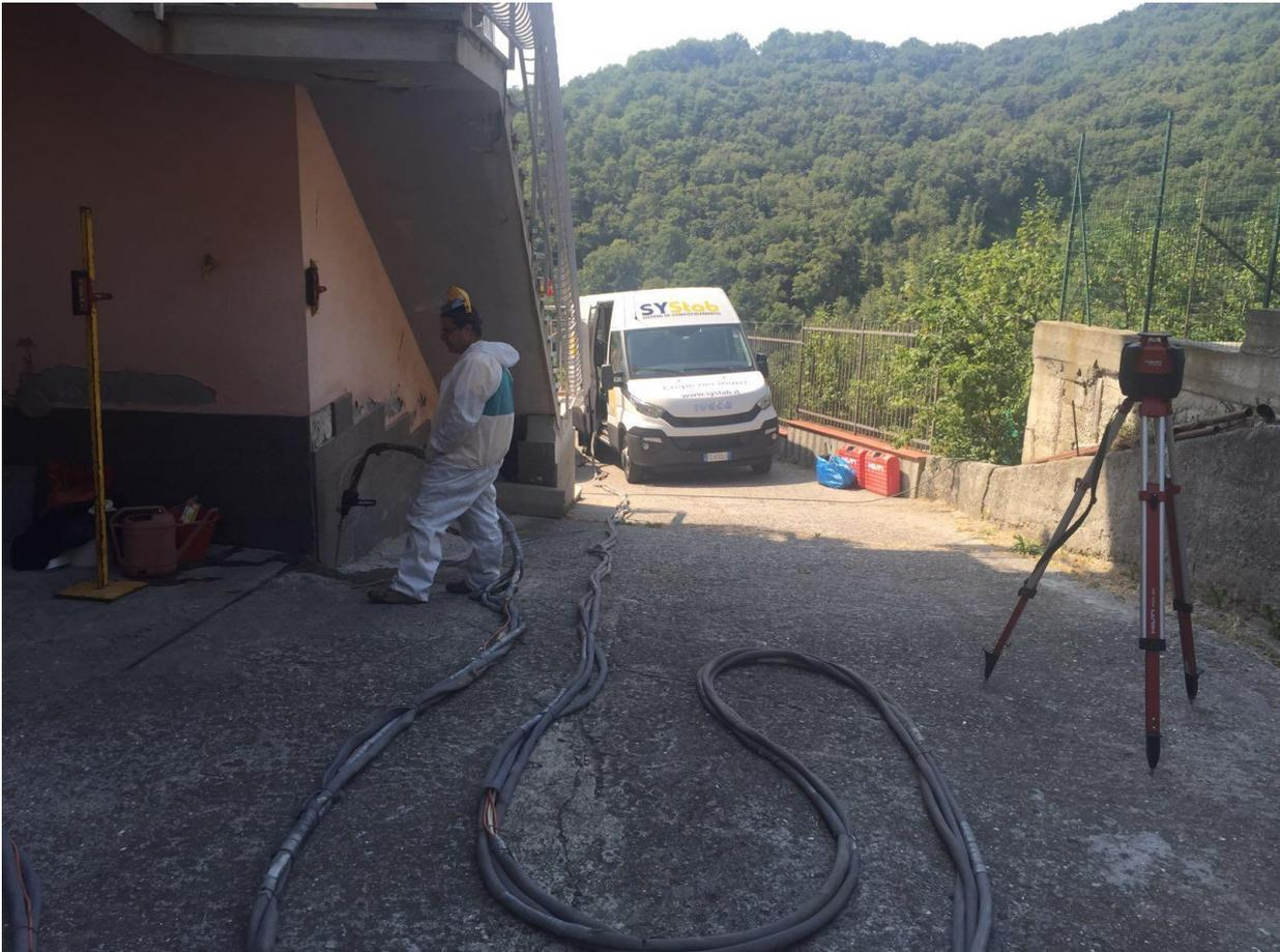
L'iniezione alternata delle due resine permette di ottenere nel nodo terreno - fondazione:
