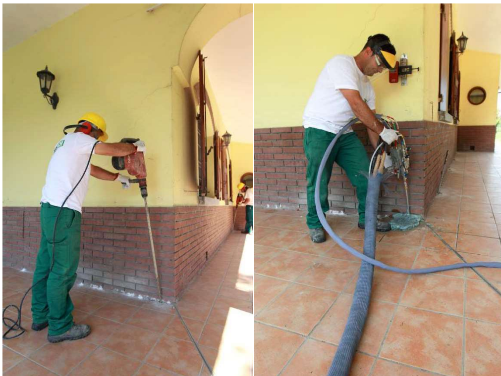
Fig. 1 – Fasi di perforazione e di iniezione durante un intervento di consolidamento con resine espandenti
