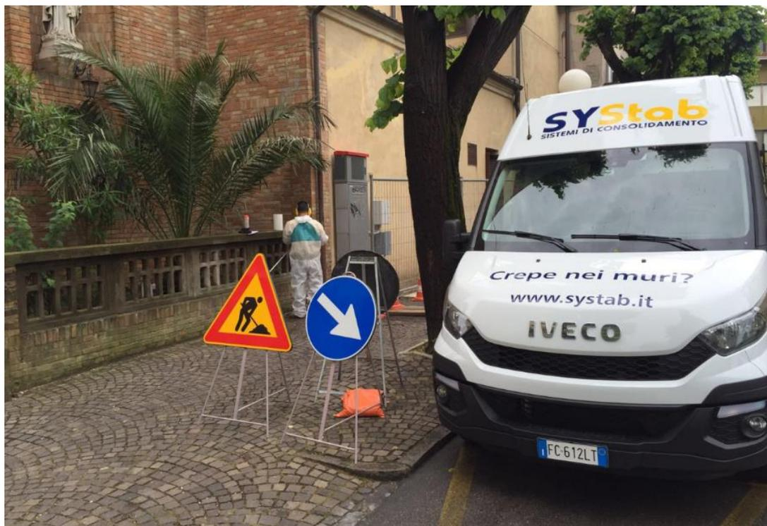
L'intervento è stato realizzato in 2 giorni, senza necessità di scavi mediante l'esecuzione fori di diametro 25 mm alla base delle murature da consolidare. In fase di cantiere sono state eseguite 3 prove penetrometriche pre e post iniezione al fine di verificare i risultati di miglioramento ottenuti nel volume di terreno significativo per i carichi della struttura.
