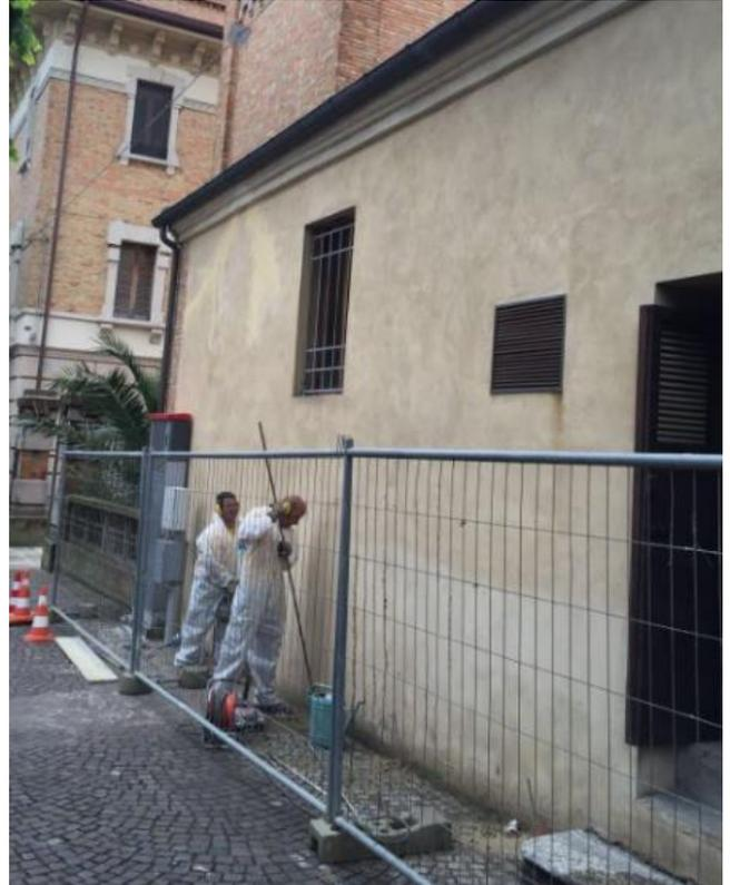
L'iniezione alternata delle due resine permette di ottenere nel nodo terreno - fondazione:
