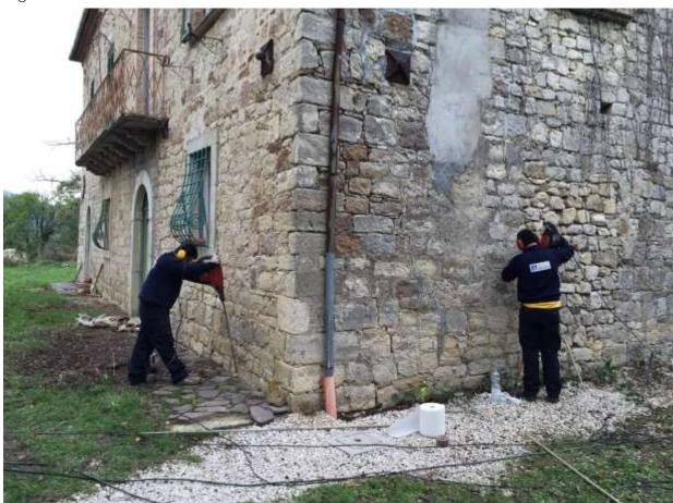
SYSTAB dopo aver realizzato un accurato rilievo del quadro fessurativo ha progettato un intervento di consolidamento mediante iniezione di resine a lenta espansione direttamente al di sotto delle murature lesionate.
