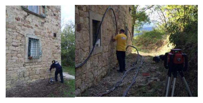
Il modello di iniezione con i risultati di miglioramento dei parametri geomeccanici è stato verificato mediante una serie di indagini pre e post iniezione (penetrometrie dinamiche e statiche) eseguite in corso d'opera, le quali hanno permesso di verificare la corrispondenza dei volumi iniettati a quanto previsto dal progetto e in caso di necessità di adeguare la maglia di iniezione alle reali condizioni geotecniche riscontrate.
